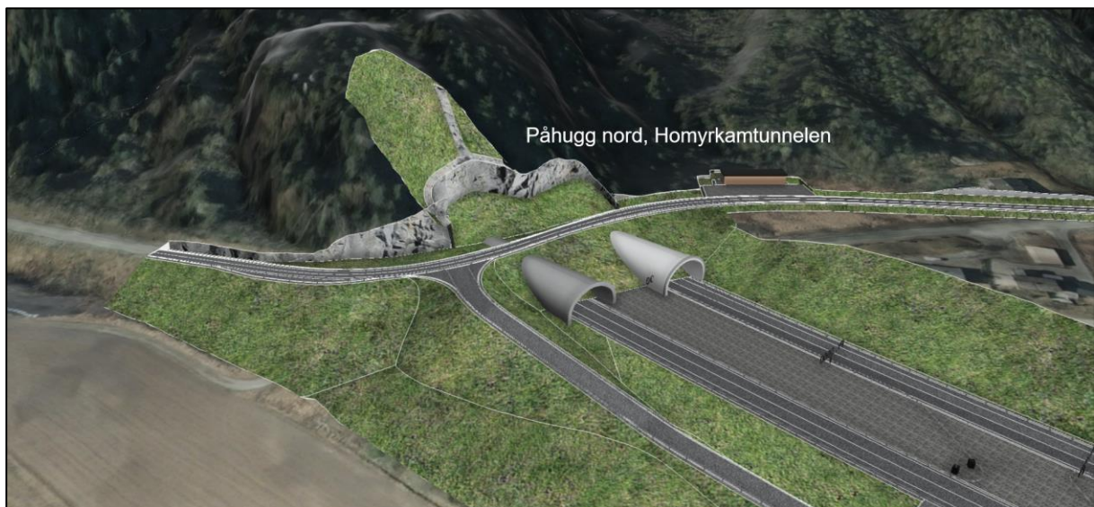
Figur 2-3: Homyrkamtunnelen, påhugg nord. (Kilde: Norconsult).
